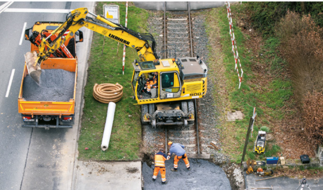
Arbeiten am Gleisbett – der Oberbau, bestehend aus Schienen, Schwellen und Bettung, ist gut sichtbar.
